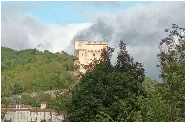
De gevangenis toren in Crest.
