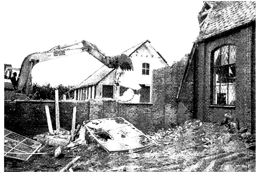
Ruimte maken voor de nieuwe kerk. Afbraak van de oude kerk en woningen.
