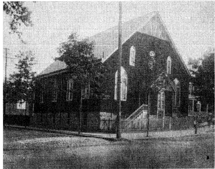
Het kerkgebouw aan de Haledon Avenue te Paterson.
