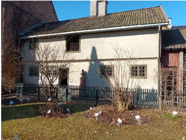
De achterkant van de gevangenis.
