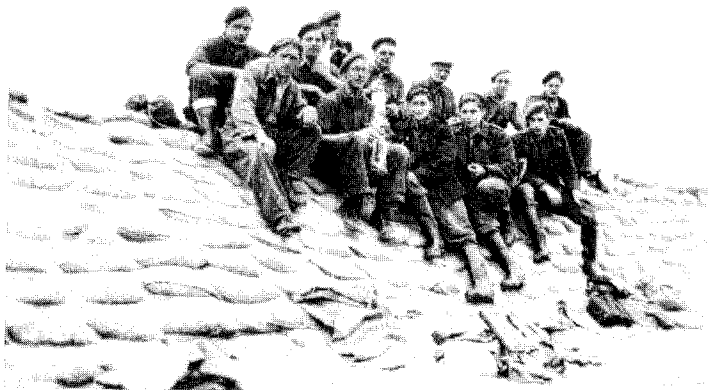
Vrijwilligers bezig met het herstel van de Nieuwerkerksedijk.
