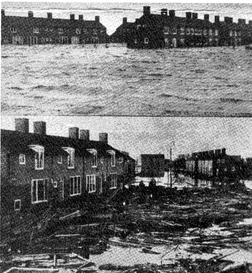
De Mauritsstraat tijdens en na de Ramp. Duidelijk is te zien hoe hoog het water stond.
