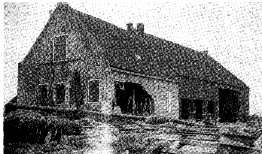
Zo zag 'Dijkzicht' er na de Ramp uit
