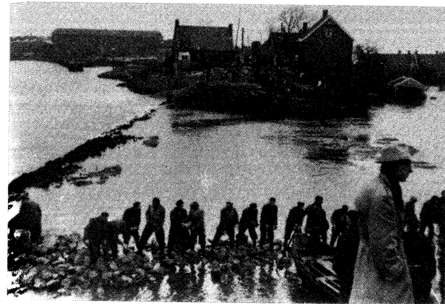
Met man en macht wordt gewerkt om het gat in de dijk bij Papendrecht te dichten.
