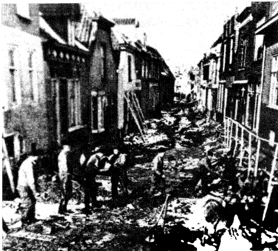
Franse genie-soldaten, bezig met herstelwerkzaamheden in de Kaaistraat te St. Maartensdijk, door welke straat in de rampnacht een enorme vloedgolf heenbrak
