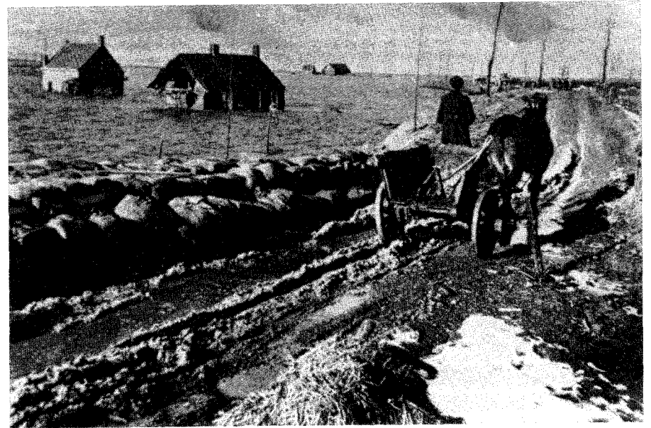
Terwijl het opruimingswerk nog in volle gang was, ging de boer weer op zijn land aan het werk. Dit is bij St. Annaland.
