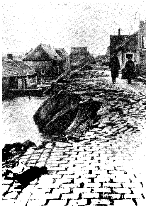
Wat er overbleef van de Stoofdijk.
