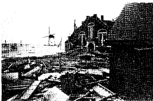
Ravage bij de kerk van de Gereformeerde Gemeente in Nieuwerkerk.
